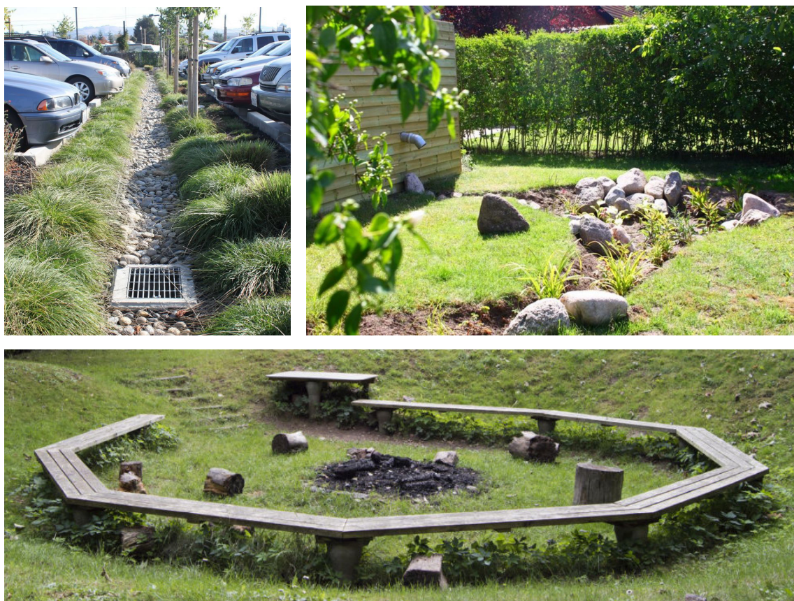
Figur 6. Fotos med eksempler på håndtering af klimavand - render med sten og blåplads i lavning
